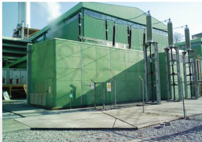
CENTRAL DE CICLO COMBIANDO PORTUGEN CANÓPIA DO TRANSFORMADOR
